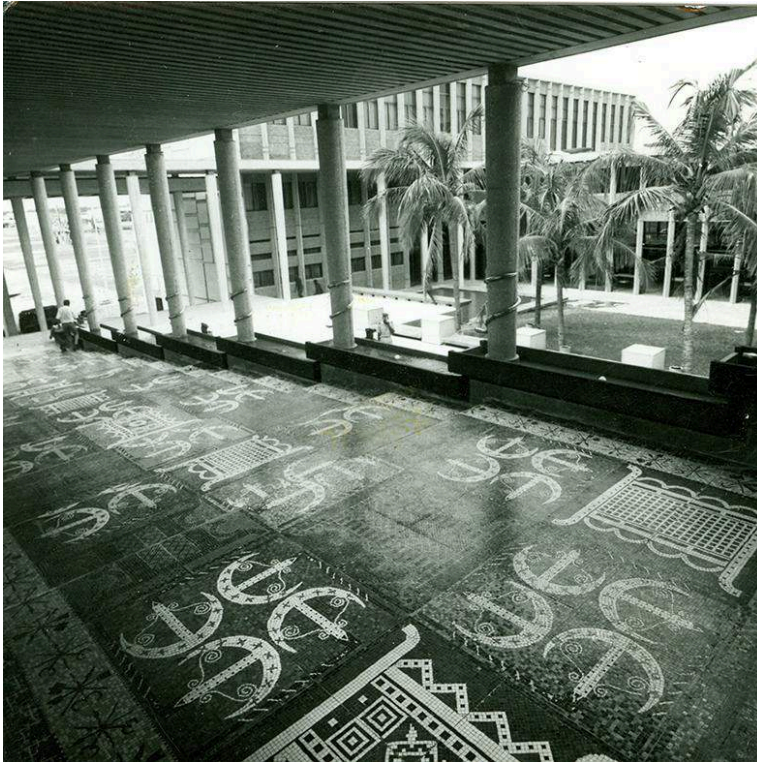
Escalier d'honneur du palais national de Cotonou en République du Dahomey, aujourd'hui Bénin (archives des BEHC).
